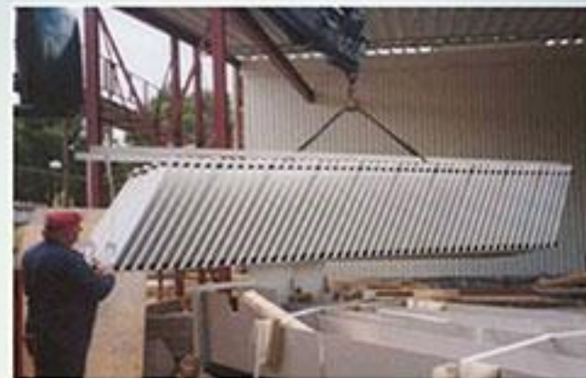
Нижняя часть осветлителя с тонкослойными модулями
