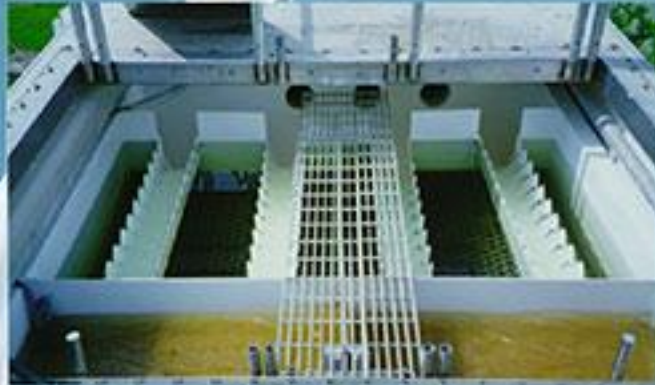
Осветлители с тонкослойными модулями
