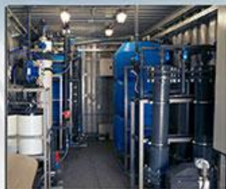
ОАО «Денеб»- установка ультрафильтрации производительностью 20м 3 /час
