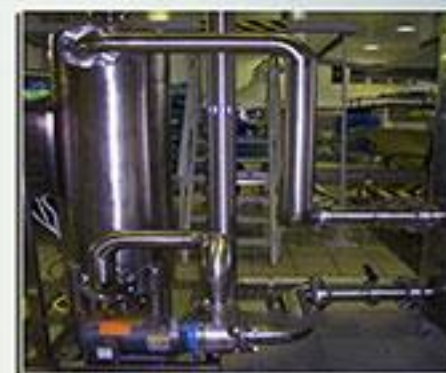
ООО «Нестле ВотерКулерс Сервис»- система озонирования воды производительностью по озону 150г/час
